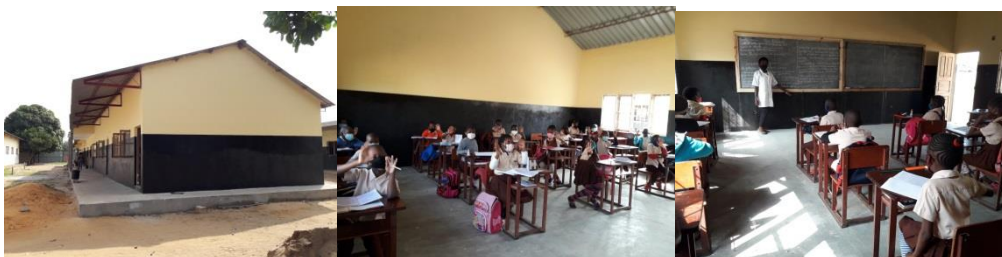
교실들 보수 공사와 새 교실 건축
